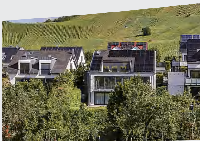
户用屋顶电站
