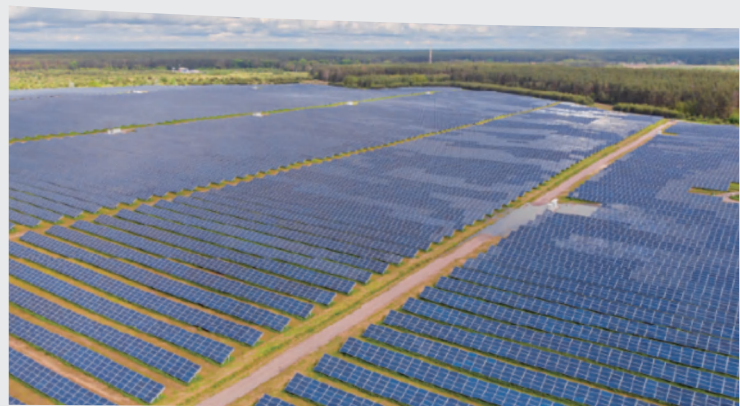
○ 大型地面电站
