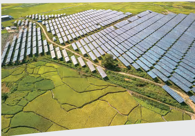
○ 山地光伏电站
